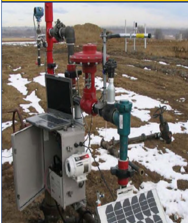
Ilustración 5: Equipo típico de cabeza de pozo y telemetría para sistemas de control automático de un sistema de aspiración de émbolo
