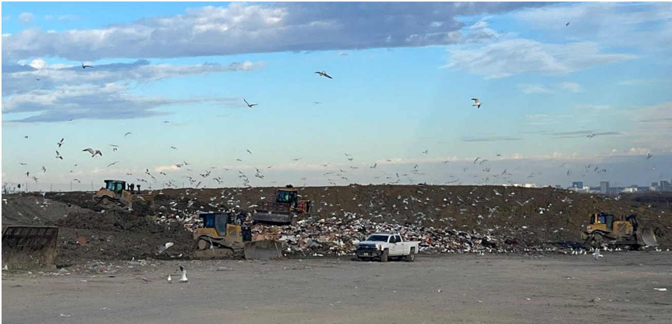
Figura 5: Uso de equipo para la colocación y compactación de residuos en un relleno sanitario
