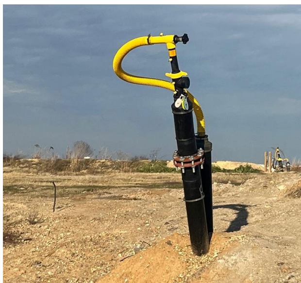
Figura 7: Pozo de captación de gas de vertedero con cabezal de control y monitoreo
