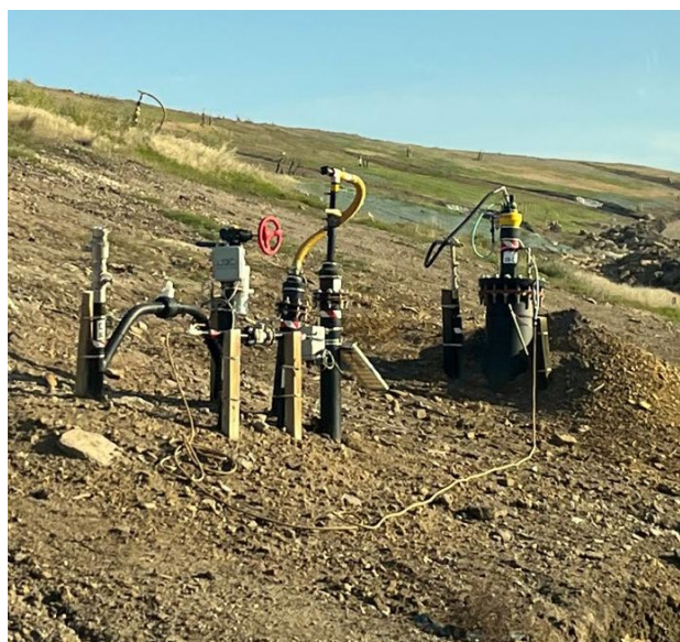
Figura 7: Pozo de captación de gas de vertedero con cabezal de control y monitoreo
